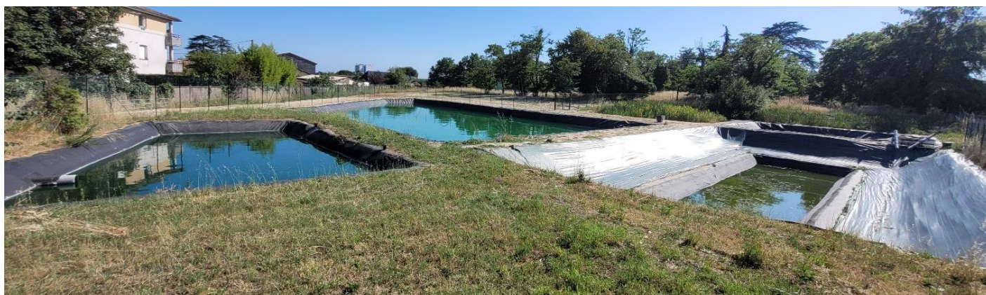
Fig1. Vue générale des bassins rénovés © JM.Deogratias, ASTREDHOR
