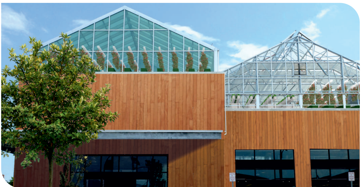
Serres en toiture (© InterregNWE GROOF)
