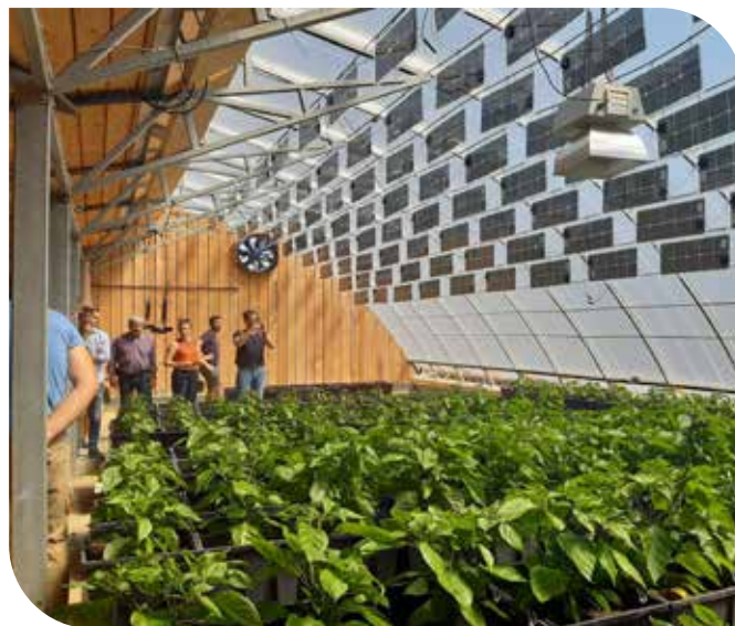
Visite pédagogique d'un pilote allemand de serre en toiture (© GroupeOne)
