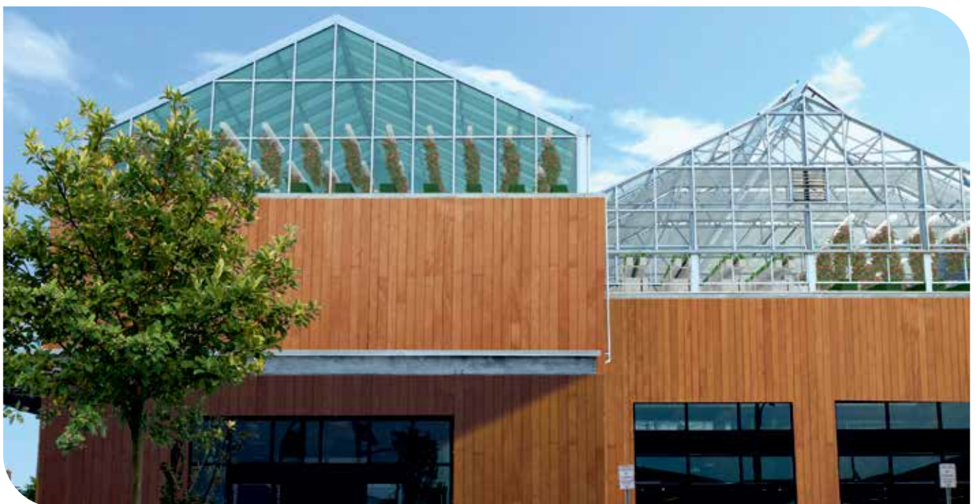
Serres en toiture (© InterregNWE GROOF)
